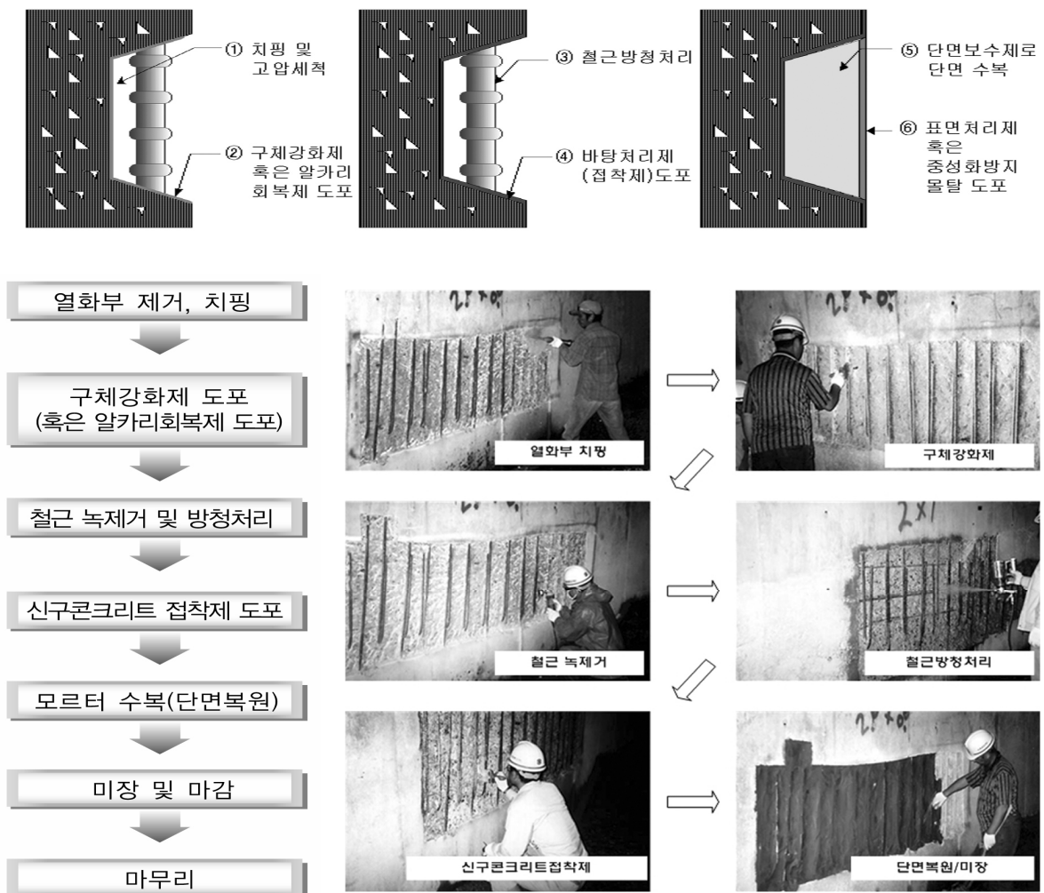
<그림 7.1.7> 단면보수공법 개요 및 시공순서
